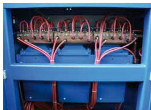
Uspořádání transformátoru a usměrňovače
